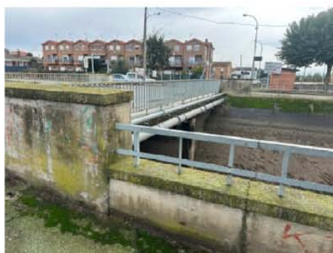
Foto 3.- Creuament del canal del carrer Estació
