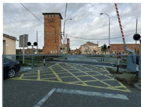
Foto 4.- Creuament del ferrocarril del carrer Estació
