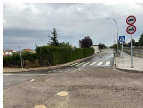
Foto 5.- Final de l'actuació. Avinguda del Carrilet
